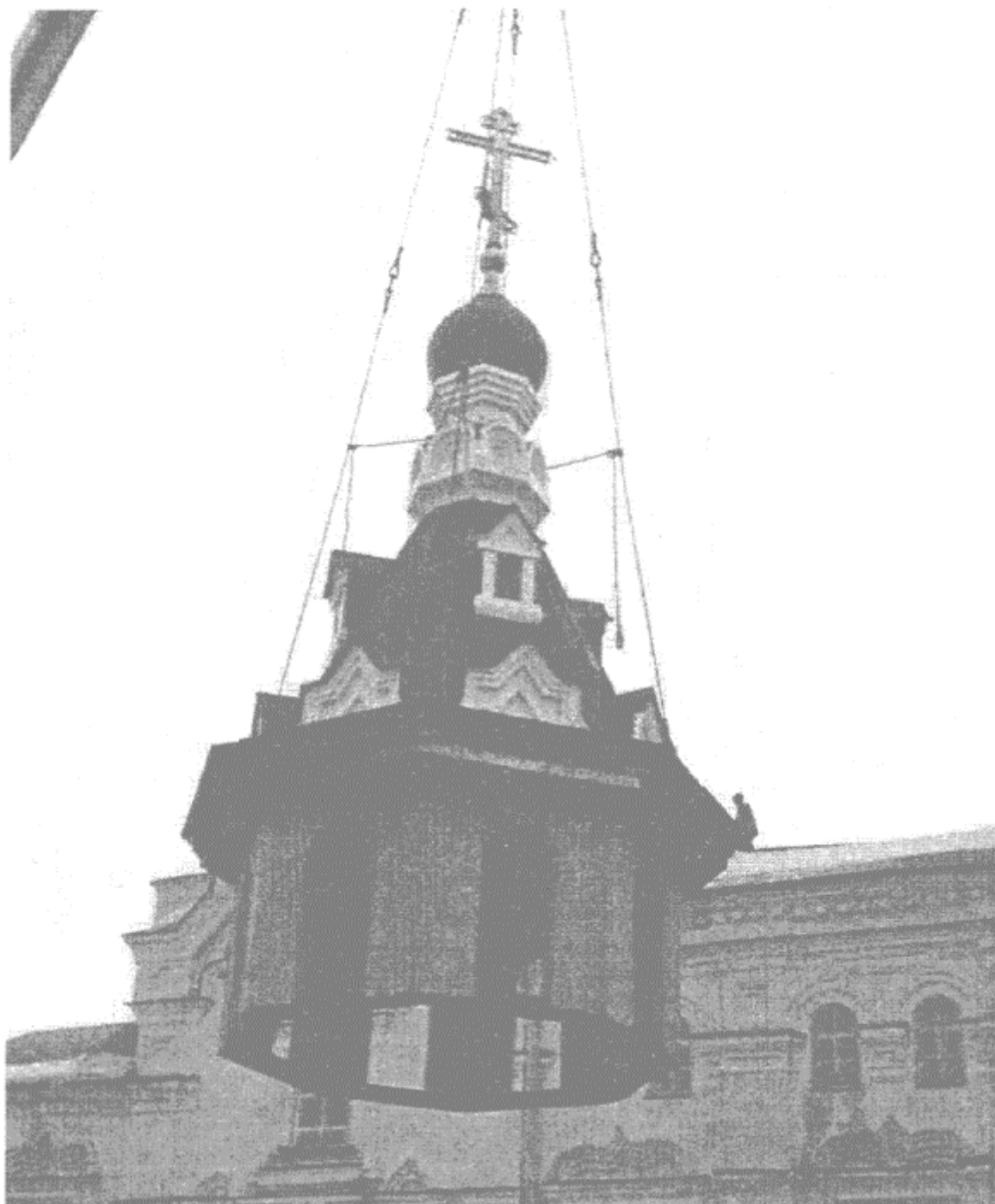
Рис. 59. Подъем готового завершения храма в Свяжске, 2001 г.
