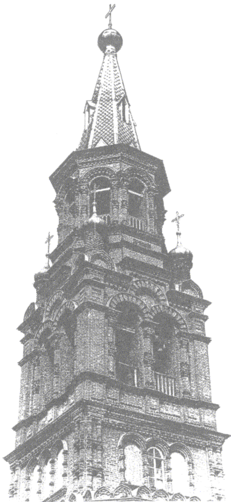
Рис. 23. Колокольня храма в г. Осташкове. Кирпичная кладка фасадов
