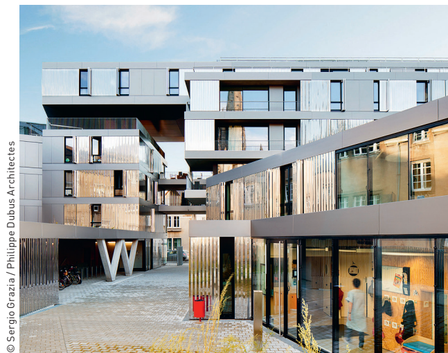
Жилые секции дома расположены на стилобате с общественно-деловой инфраструктурой 56 Apartments in Nantes (Нант, Франция)
