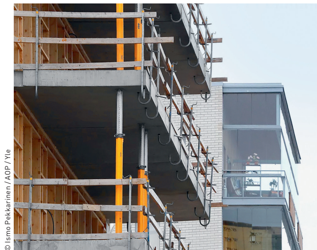
Внешняя стена и балконы из монолитного железобетона
