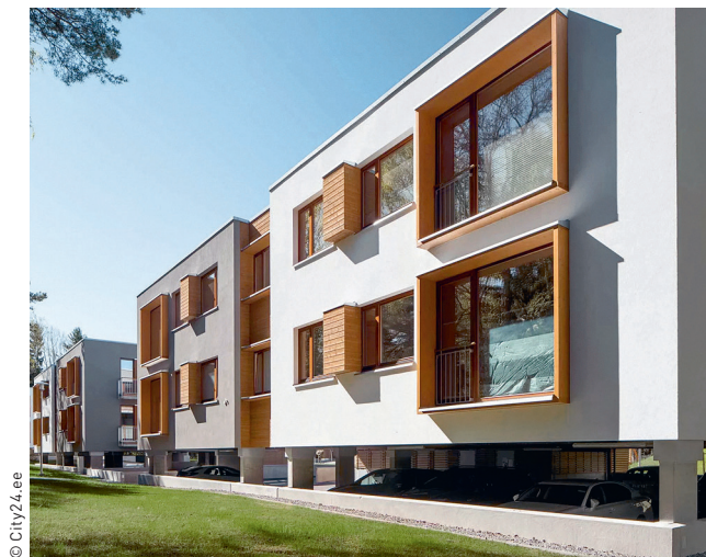
Открытая полуподземная автостоянка под домом Kakumäe tee 94 apartment building (Таллин, Эстония)
