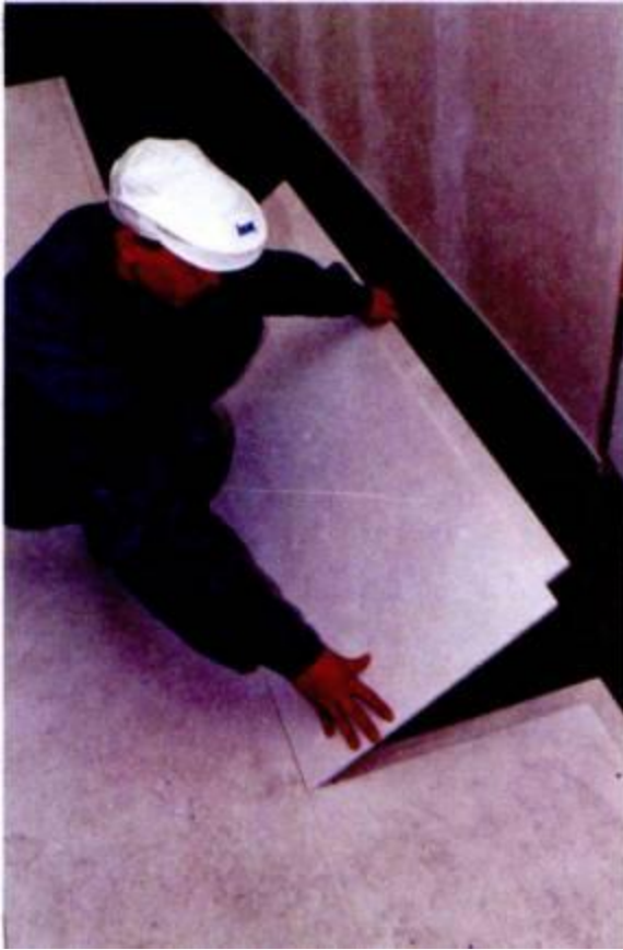
Укладка сборной стяжки основания из элементов пола
