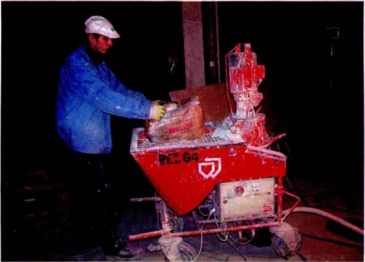
Приготовление штукатурной растворной смеси в машине PFT G4
