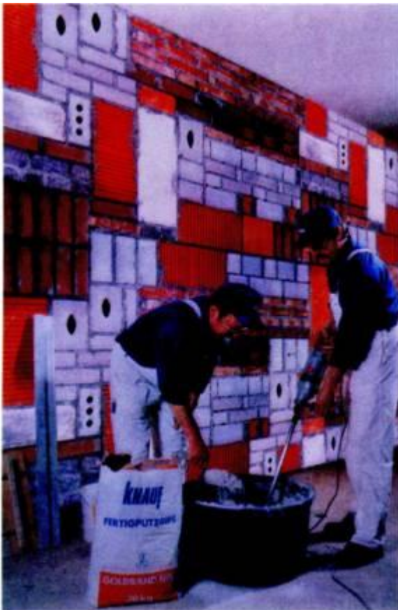
Ручное приготовление гипсовой растворной смеси
