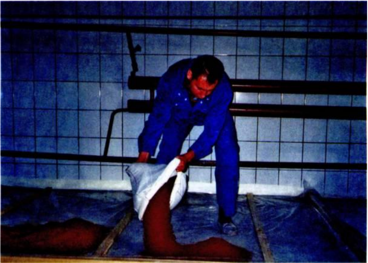
Устройство слоя сухой засыпки по слою пароизоляции
