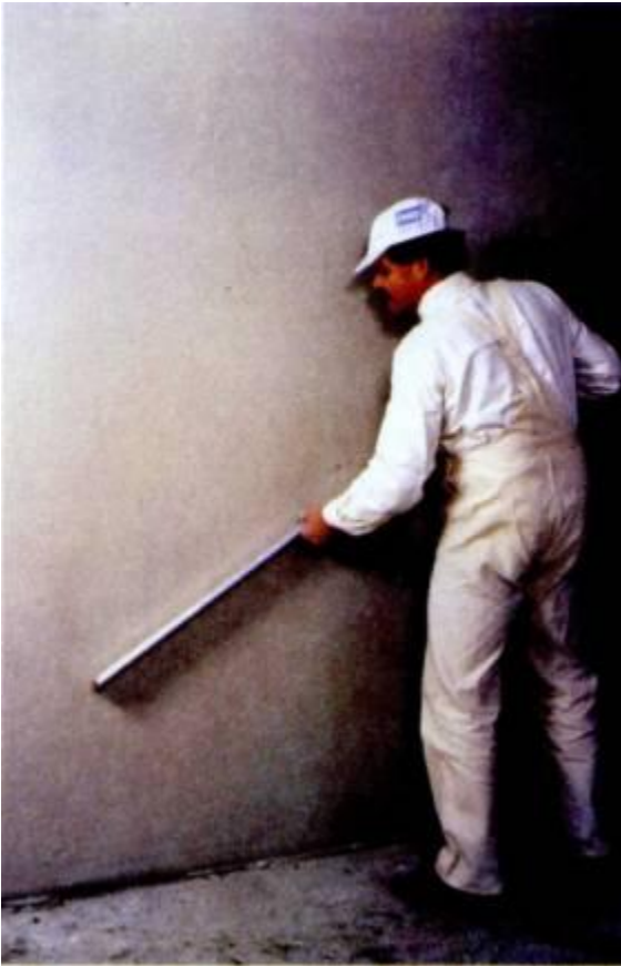
Выравнивание растворной смеси правилом
