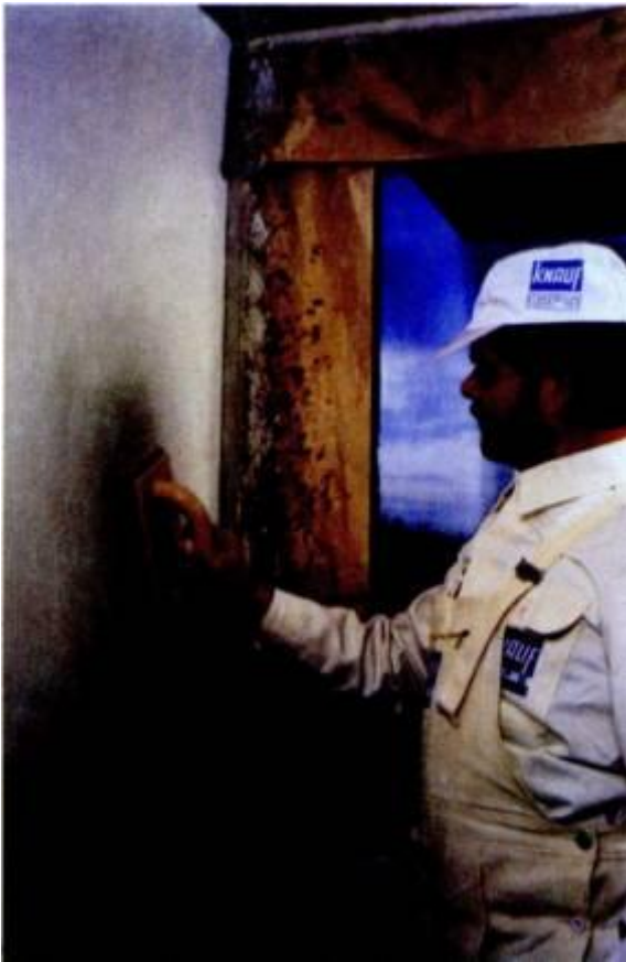
Затирка растворной смеси губчатой теркой
