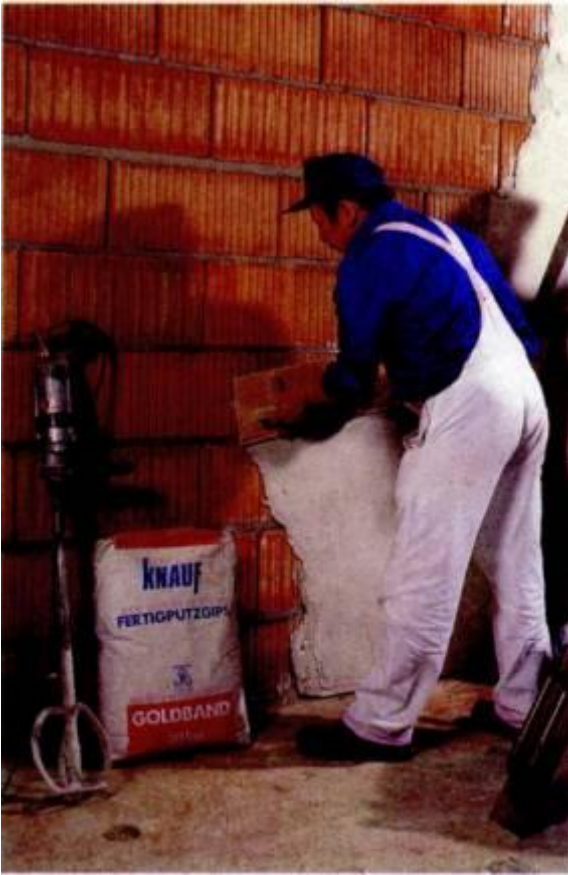
Нанесение гипсовой растворной смеси вручную
