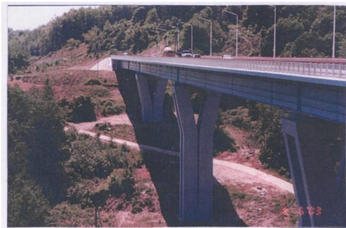
Фото 8. Виадук на ПК36 обхода г. Сочи
