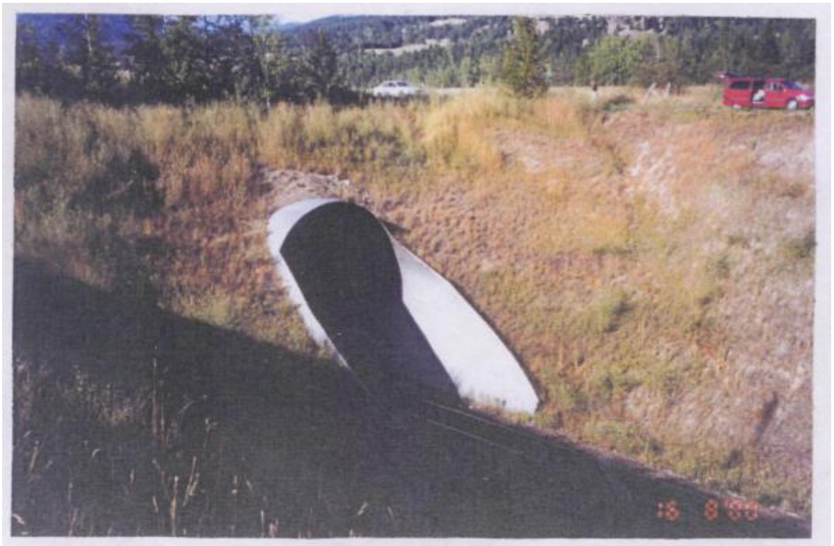
Фото 2. Железнодорожный тоннель из ГМК
