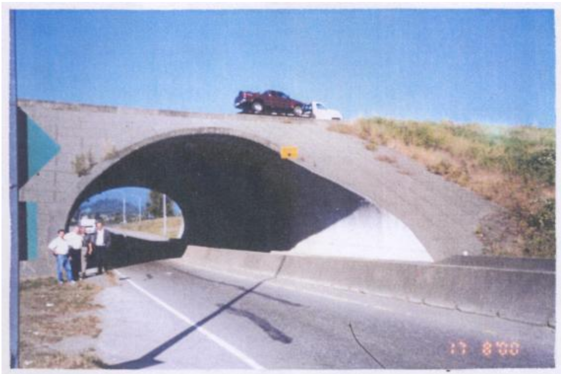
Фото 3. Тоннель для пропуска автомобилей и пешеходов под дорожной насыпью
