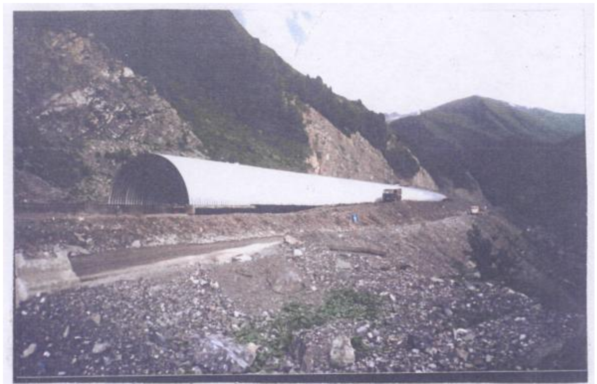
Фото 5. Строительство лавинозащитной галереи вблизи Рокского перевала (фото А.А. Махорина)
