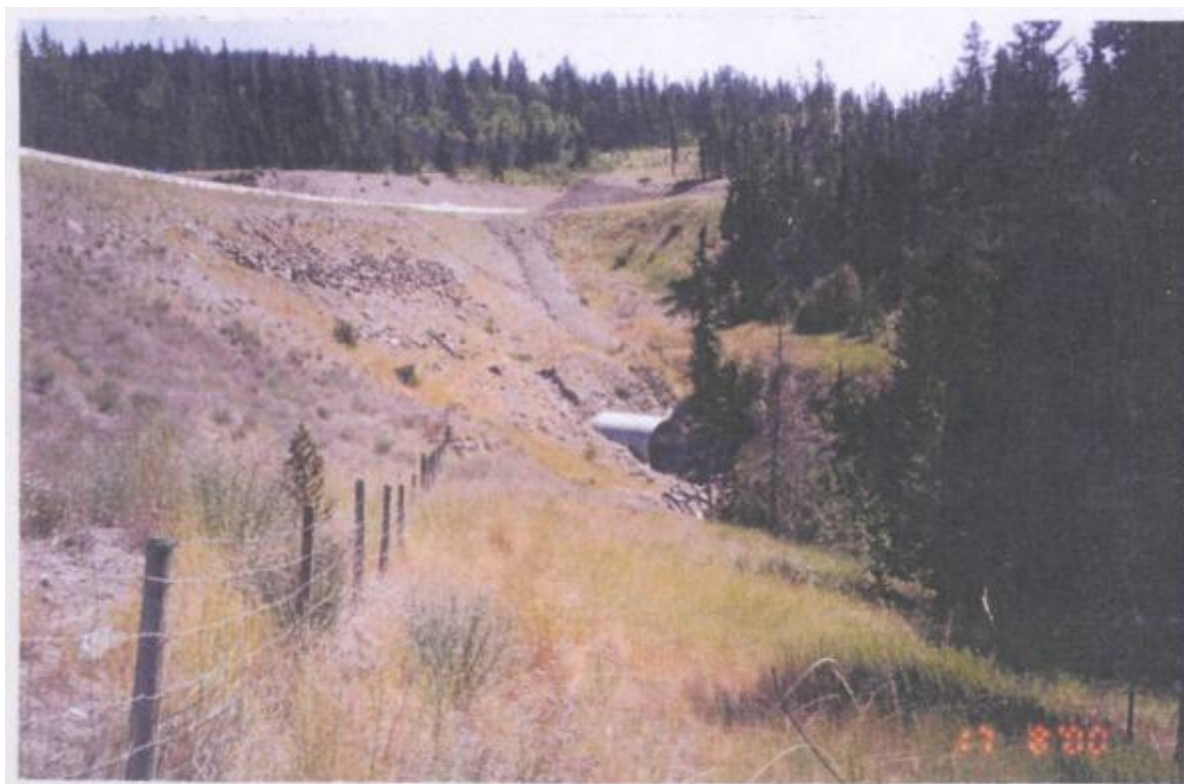
Фото 1. Труба большого диаметра под насыпью автомобильной дороги
